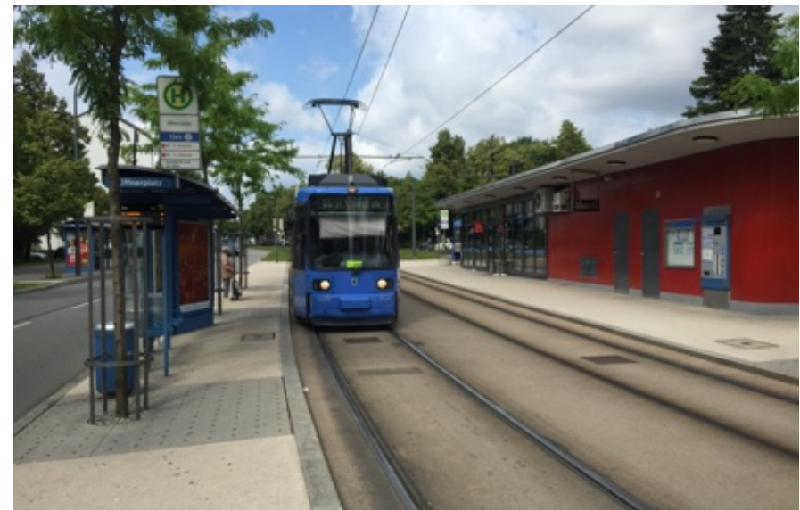
Endhaltestelle mit Kiosk und Unterwerk (München)
