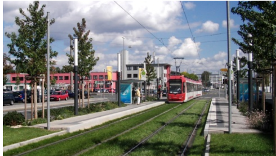
Bahnsteig mit eigener Beleuchtung (Nürnberg)
