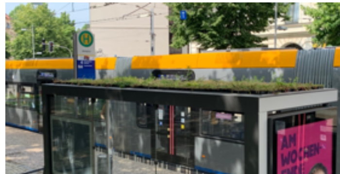
Beispiel Dachbegrünung in Leipzig
