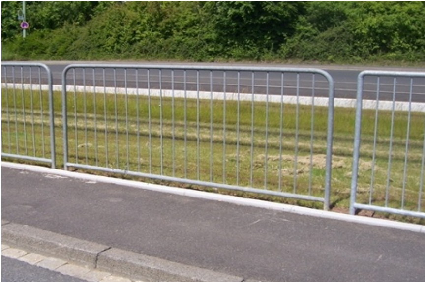
Geländer mit Übersteigschutz (Würzburg)
