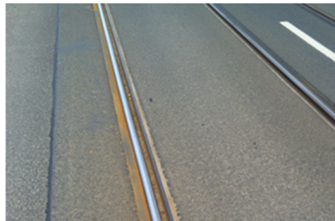
Abb. 13: Dunkelgrau – Gleiseindeckung Asphalt
