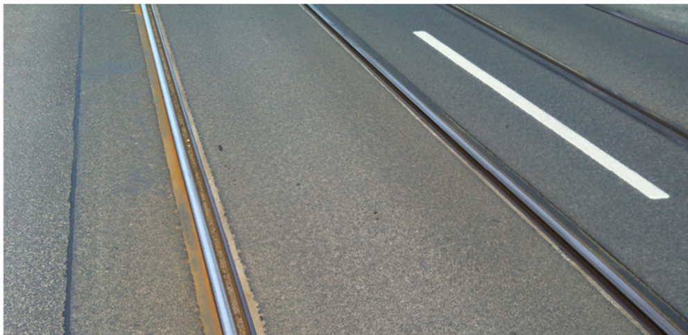
Abb. 28: Beispiel Dunkle Gleiseindeckung passend zum Fahrbahnasphalt (Leipzig)
