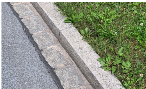
Abb. 35: Detail Granitbord und begleitende Pflasterzeile (Erlangen)
