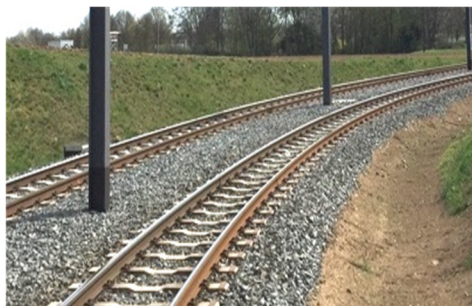
Abb. 33: Beispiel Schottergleis ohne Einfassung mit begleitender Entwässerungsmulde (Mainz)
