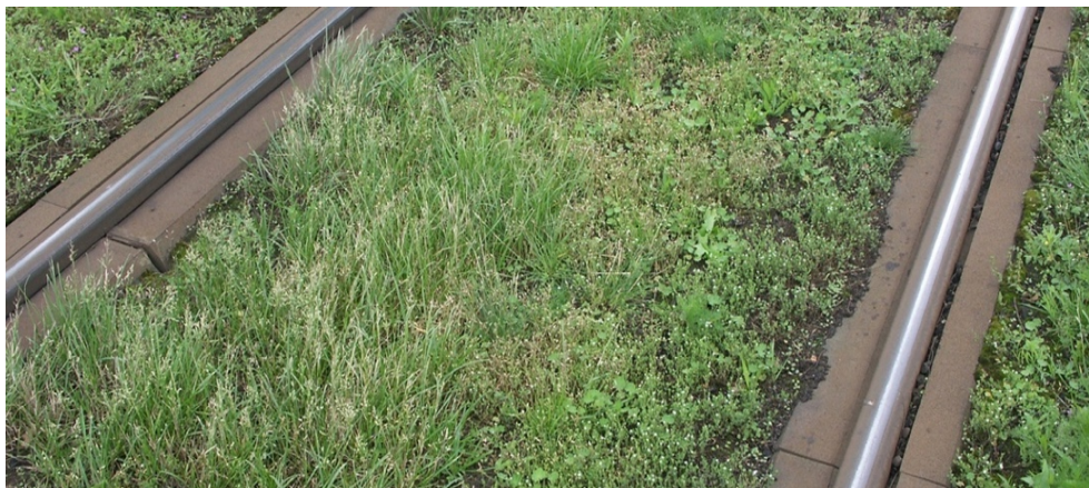
Abb. 23: Beispiel Rasengleis mit hochliegender Vegetationsdecke und Kammerfüllelementen (Nürnberg)
