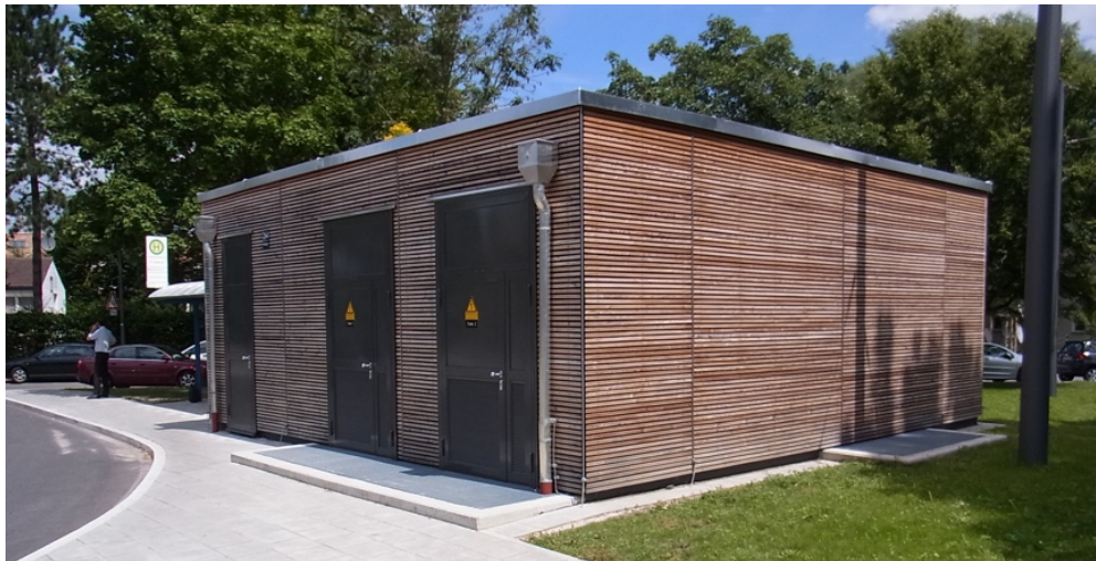
Abb. 48: Ausführungsbeispiel Gleichrichter-Unterwerk mit Holzverkleidung (München)
