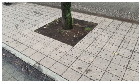
Abb. 94: Beispiel Abdeckung Wurzelbrücke mit Lochplatten passend zum Bahnsteigbelag
