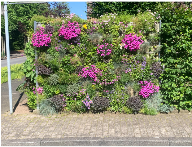
Abb. 96: Beispiel Gabionen-Element mit Steingartenpflanzen als begrünter Spritzschutz
