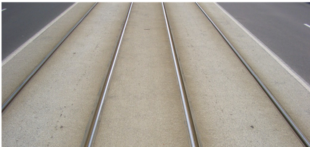
Abb. 30: Beispiel helle bzw. beige wirkende Gleiseindeckung auf besonderem Bahnkörper in farbllichem Kontrast zur dunklen Straßenfahrbahn (Leipzig)
