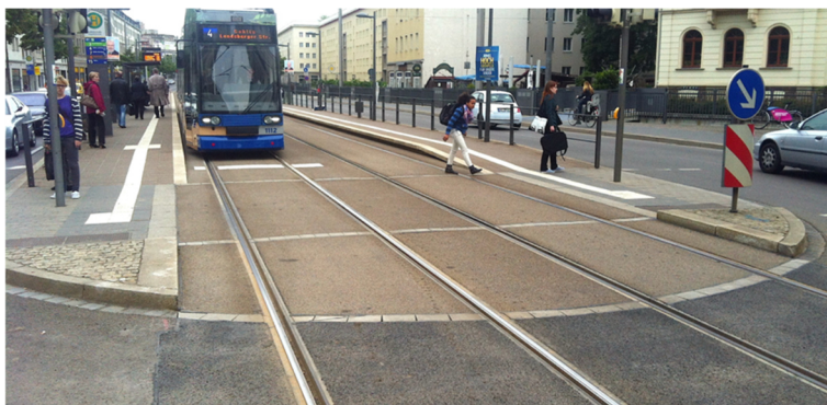
Abb. 38: Ausführungsbeispiel Pflasterzeile im Knotenbereich (Leipzig)
