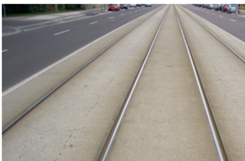
Abb. 14: Beige – Gleiseindeckung Mineralisch
