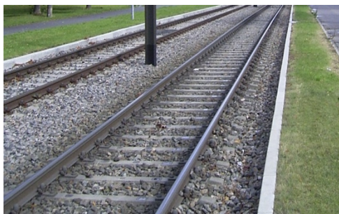
Abb. 32: Beispiel Schottergleis mit Einfassung durch Bord (Rostock)
